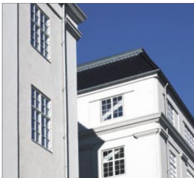
AB Amagerbro, København Facaderenovering 2006, kombineret RockVision og RockBase FacadeSystem
